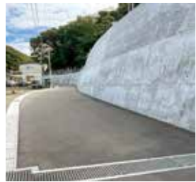
令和5年度に緊急自然災害防止対策事業として、1億2800万円で補修工事が行われた市道五日町在府小路線
