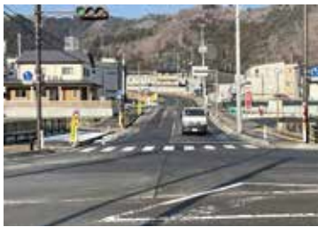
土地区画整理事業（二戸駅川原橋線周辺）
