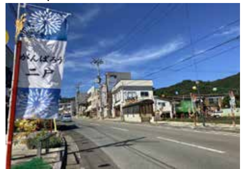
家屋の解体や移転が進む二戸駅前地区
