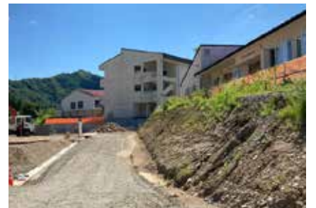
石切所公民館前を通学路に工事中
