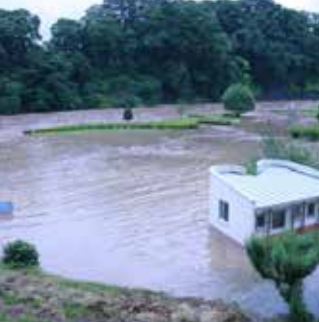
7月12日、冠水した馬淵川公園の様子。一時は、避難勧告も発令された。
