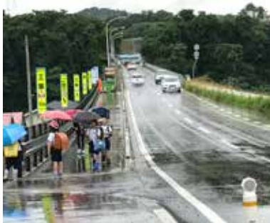
補修工事に入る斗米橋
