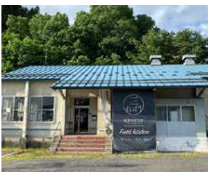
空き状態だった旧浄法寺給食センターを活用した、農産物加工場「フィールドキッチン」
