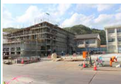
現在、改築工事中の福岡工業高校
