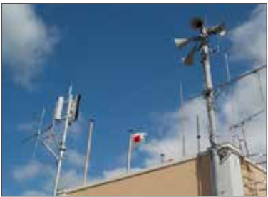
防災行政無線のアンテナとスピーカー(右手前が旧型、左奥が新型)
