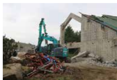
温泉センター解体時の様子
