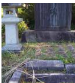
市武道館脇にある馬魂碑の階段部分が破損している
