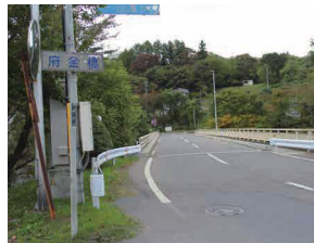
補修工事が完了した府金橋
