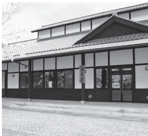
改修により生産・販売機能の増強を目指す浄法寺漆芸の殿堂「滴生舎」
