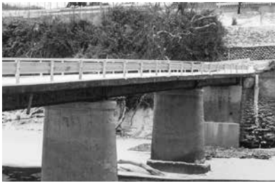
補修工事が予定されている下豊年橋
