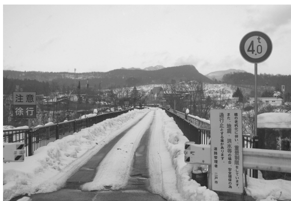
重量制限4tの青岩橋
