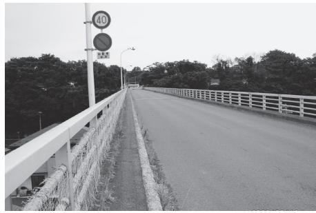
斗米橋の歩道（堀野）
