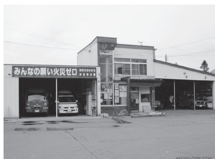
二戸消防署浄法寺分署
