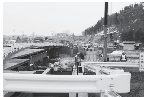
川原橋橋梁架替工事
